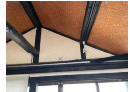
店内装：大幅に改修されているため漆喰壁等に復元する
