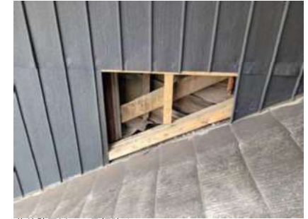
蔵外壁平側：下見板貼り
