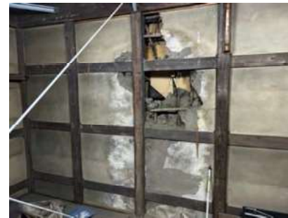
蔵内部壁：土壁漆喰
