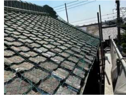
蔵屋根：日本瓦葺
