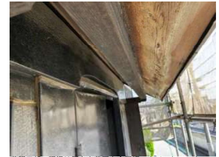
蔵開口部：現況は既存土蔵扉を金属板でカバーしている
