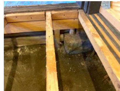
店基礎：大谷石基礎、東石ともコンクリート基礎へ更新
