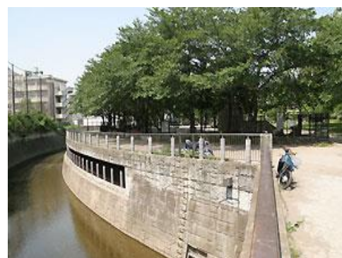
◇洪水調節池の整備と公園が連携している例（壁面に開いているのは取水口）（落合調節池と落合公園：新宿区）
