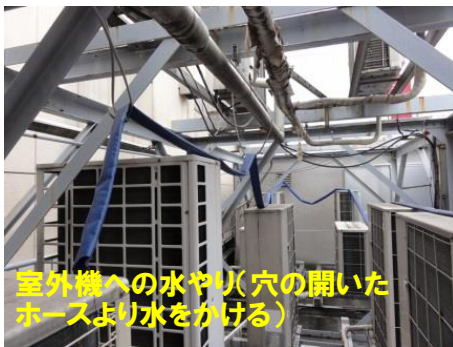
(参考) 室外機への水噴射前後の消費電力の変化
