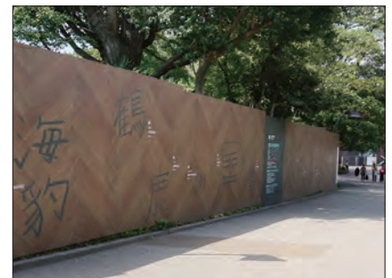
周辺や施設の雰囲気に配慮した仮囲いの例
