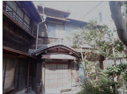
彫刻家のアトリエ兼住居として建てられ、現在有志により維持管理され、定期的に公開され、イベントスペースなどに活用されている。
